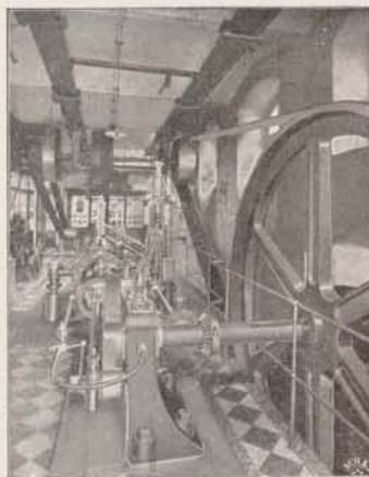
Maschinen-Haus und electricische Kraft-Centrale.
