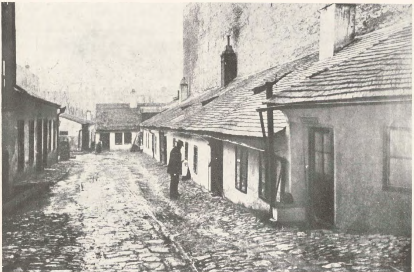
Obr. 12. Obydlí ve dvoře na Velké Nové ulici (dnešní Lidická) (k článku K. Fojtíka).
