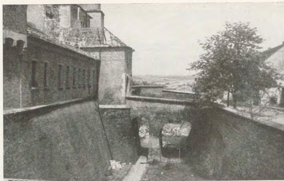
48. Také Brněnský hrad (Špilberk) utrpěl za frontových bojů, kdy desítkami dělostřeleckých zásahů byla poškozena hlavně krytina.
