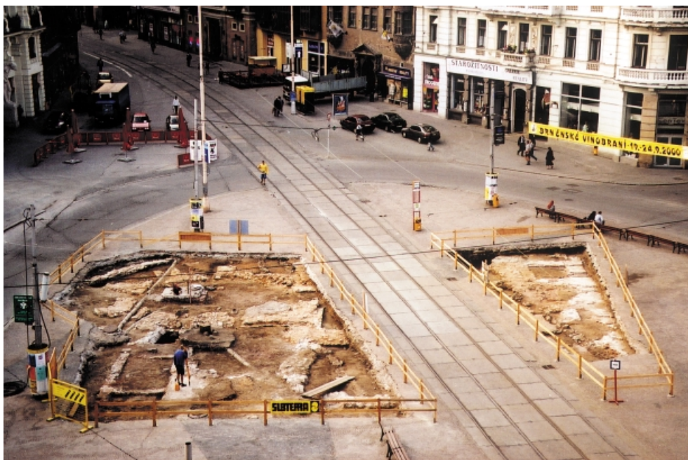
Příloha č. IV: Pohled na odkryté základy kostela sv. Mikuláše od severu. (K článku Kostel sv. Mikuláše...)
