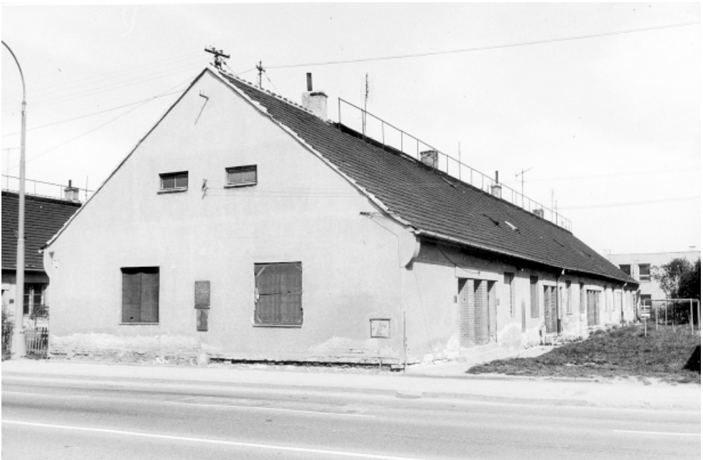
Příloha č. 40: Kolonie na ulici Hněvkovského v Komárově, 1988.
