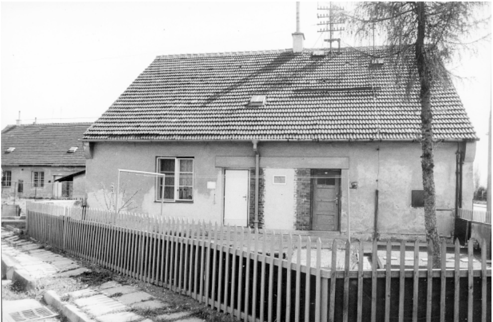
Příloha č. 40: Kolonie na ulici Hněvkovského v Komárově, 1988.
