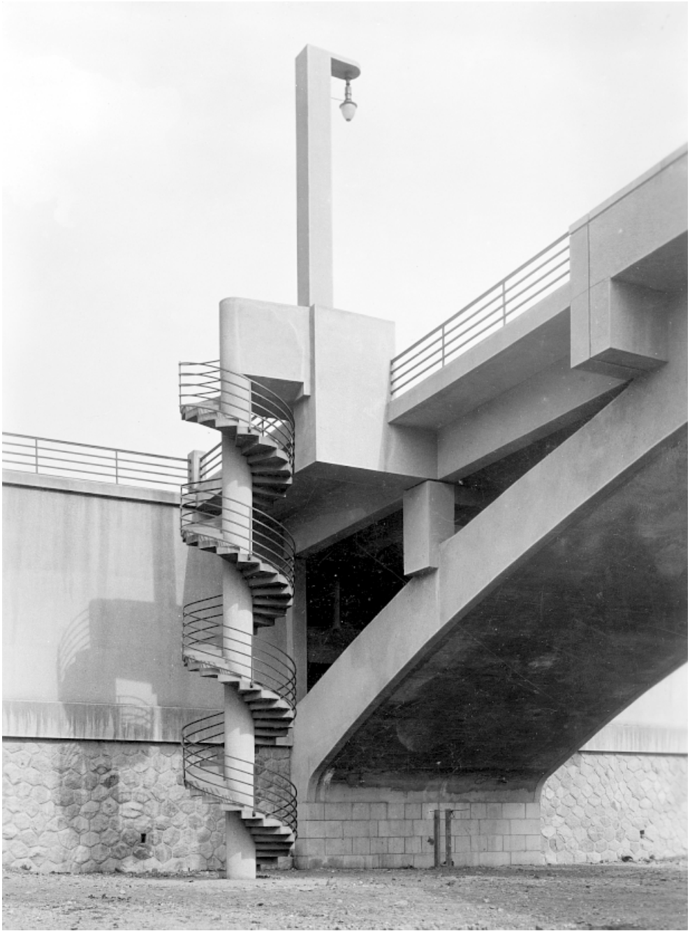
Příloha č. 12: Železobetonový most v Kralupech nad Vltavou - schodiště.
