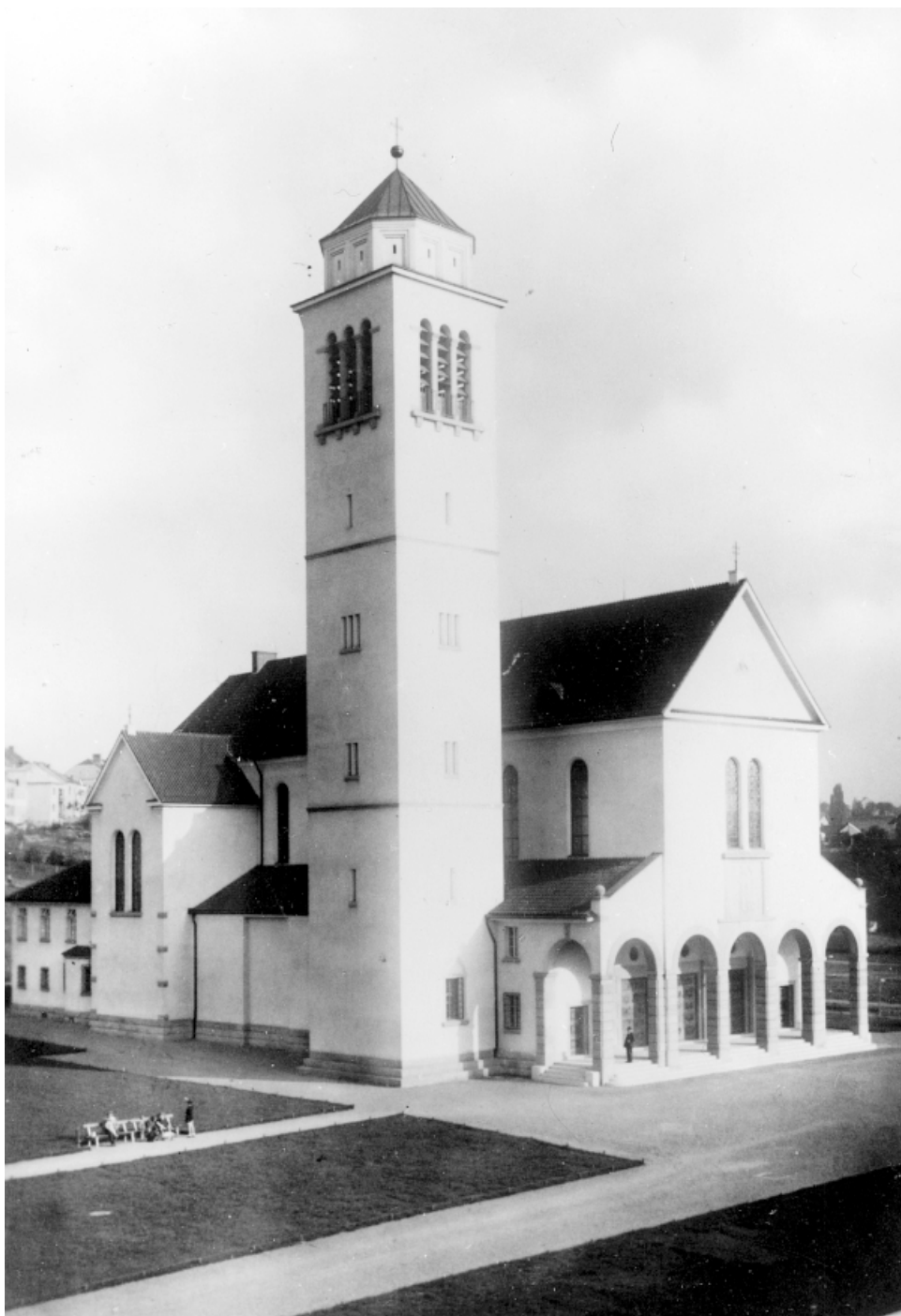
Příloha č. 8: Pohled na novostavbu kostela sv. Cyrila a Metoděje.
