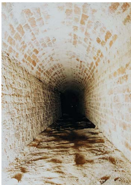
Příloha č. XXII: Pohled do severovýchodní části vodovodní štolky.
