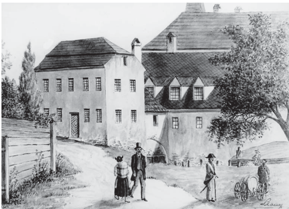
Příloha č. 6: Bývalá valcha na Radlasu, datováno do 2. poloviny 19. století.
