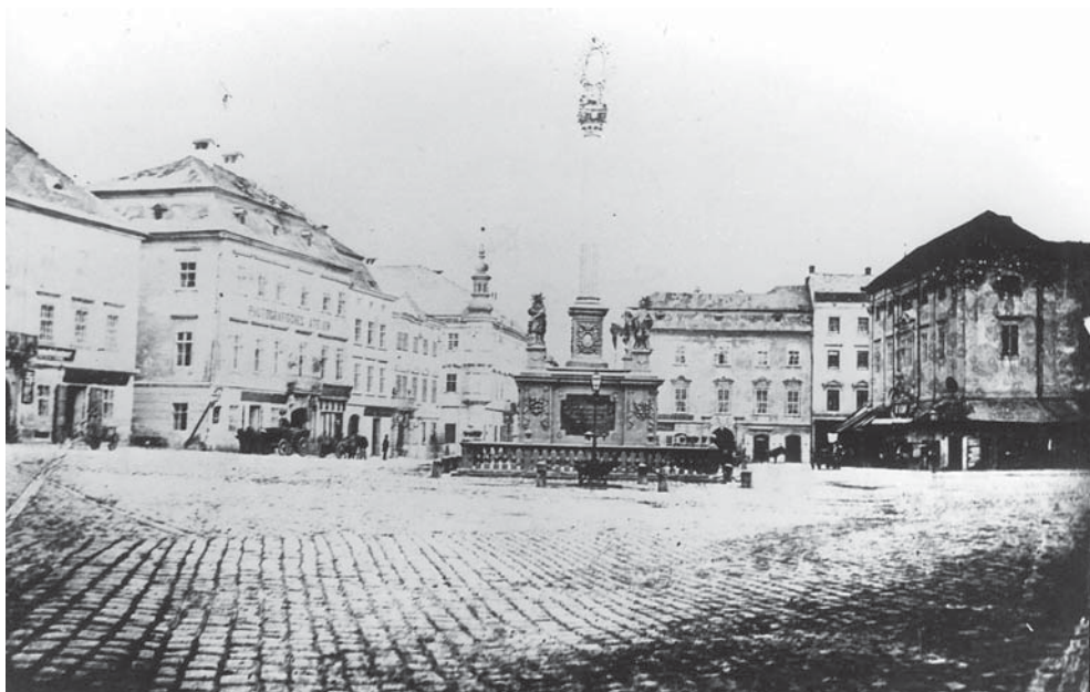
Příloha č. 11: Celkový pohled na Velké náměstí, z něhož je patrné umístění domu, kde se nacházel fotoateliér Quida Trappa.
