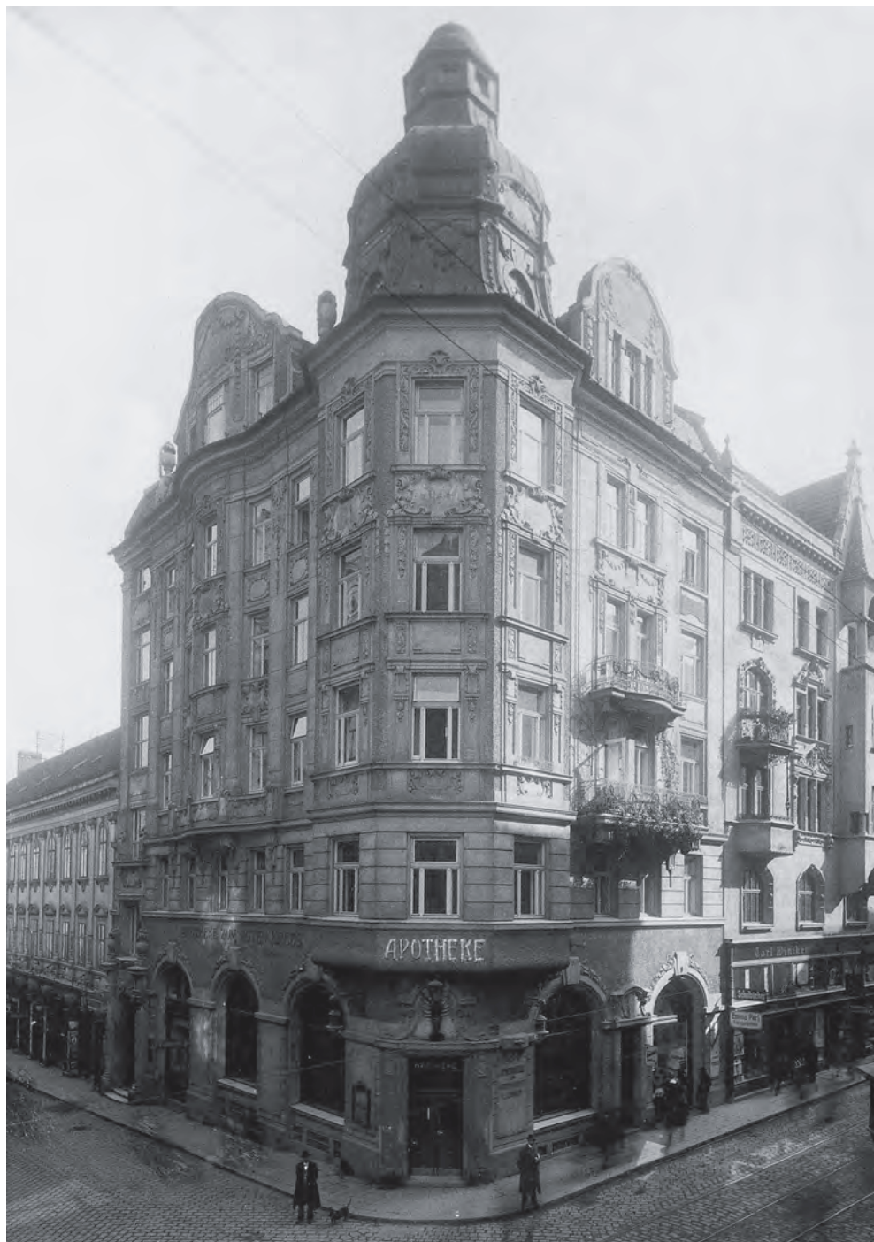
Příloha č. 10: Lékárna „U červeného raka“. (1907)
