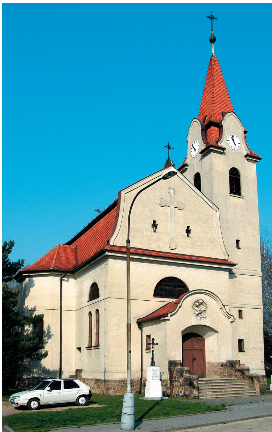
Barevná příloha č. X: Současný pohled na kostel v Horních Heršpicích – průčelí.
