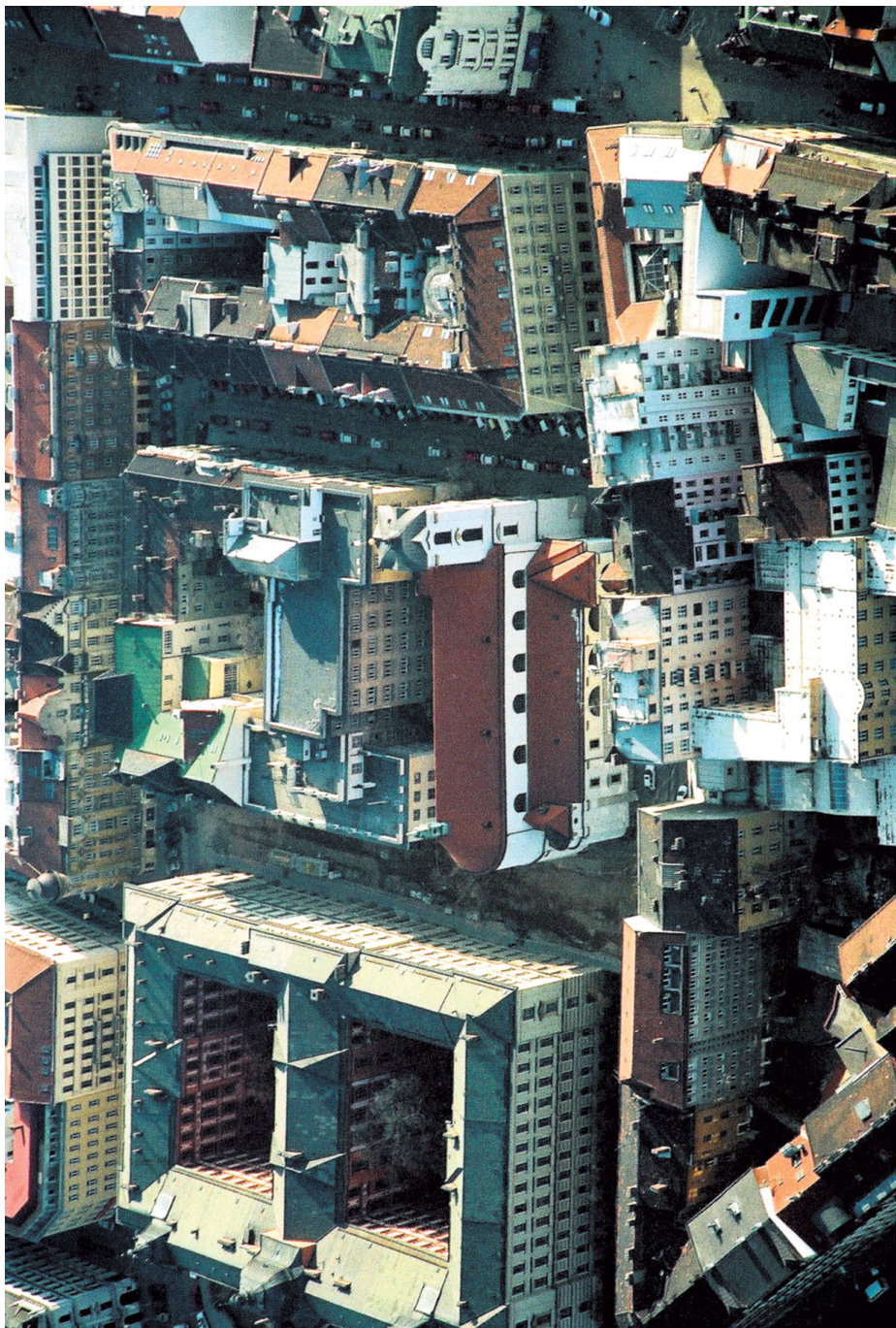
Barevná příloha č. XVIII: Letecký snímek domovního bloku 39, pohled od severu.
