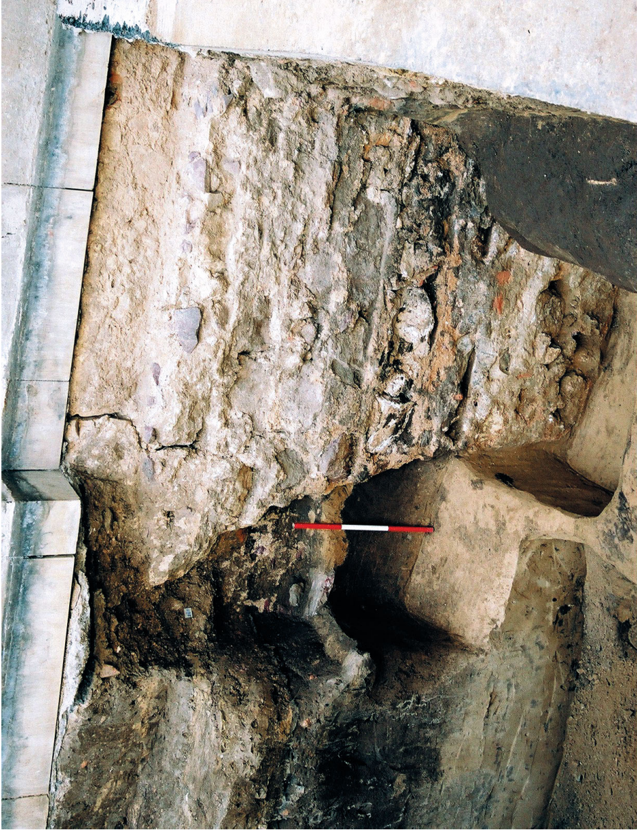
Barevná příloha č. XXVIII: Pohled na obnažené vrcholně středověké základové zdivo dnešní kaple sv. Františka Xaverského. Sonda A5, blok 39.
