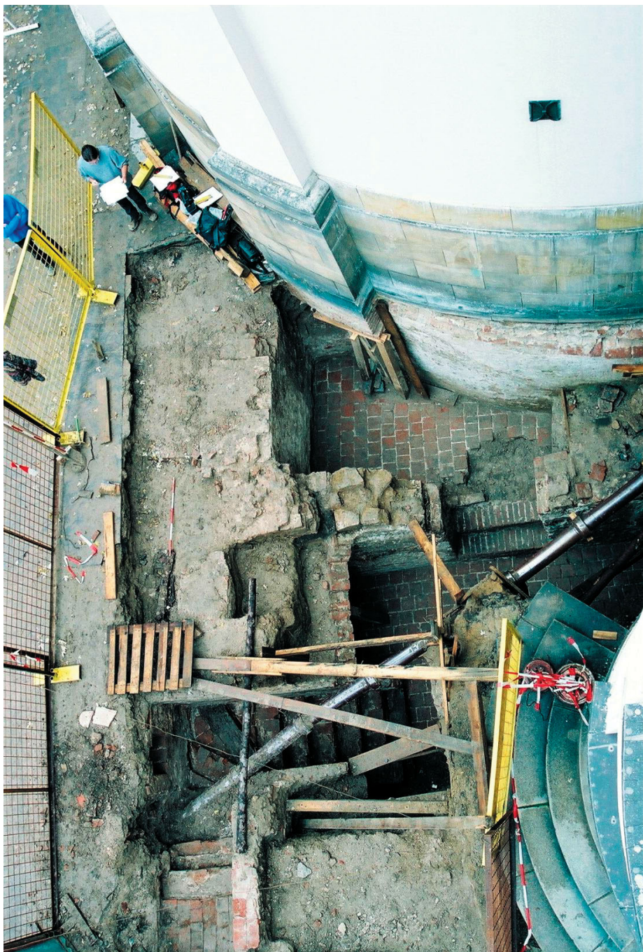
Barevná příloha č. XXIII: Část sklepních renesančních prostor severně presbytáře kostela Nanebevzetí Panny Marie.
