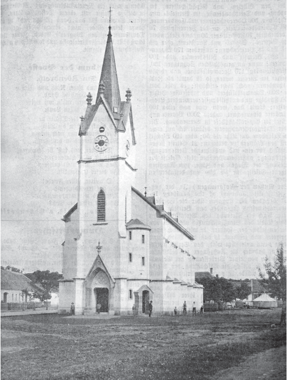
Příloha č. 1: Celkový dobový pohled na kostel v Černovicích.
