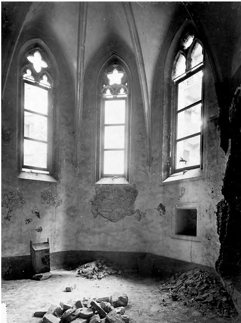
Příloha č. 22: Josef Kunzfeld (?), Interiér presbyteria kaple po odkrytí okenních kružeb, duben 1908.
