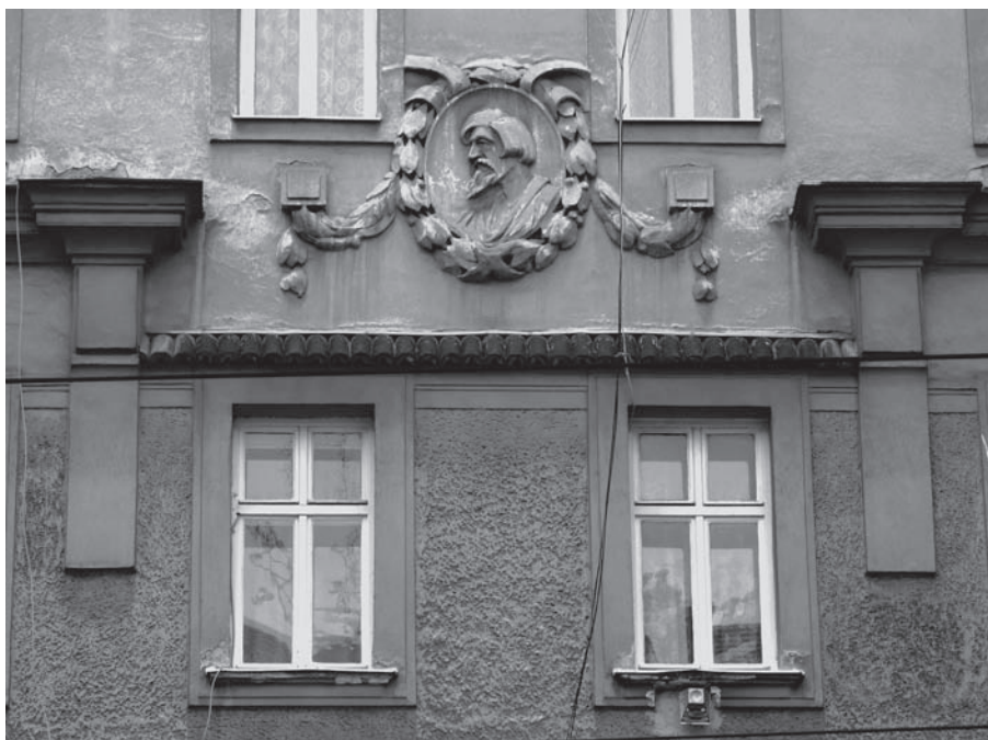
P15 Nájemní dům Merhautova 12, detail hlavního průčelí v úrovni 2.–3. patra.
