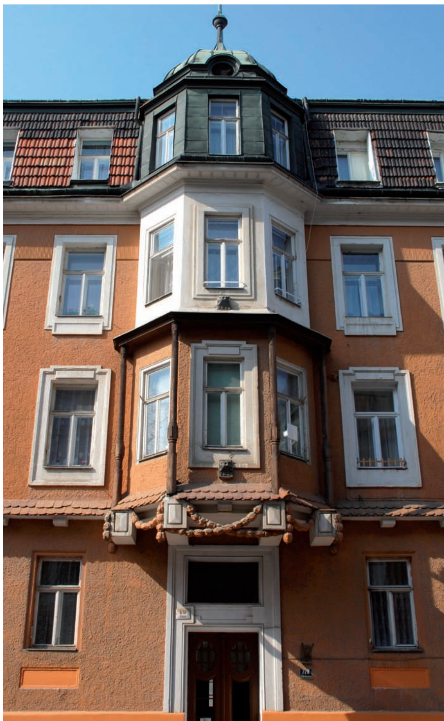
■58 Nájemní dům Slepá 19, hlavní průčelí, detail arkýře.
