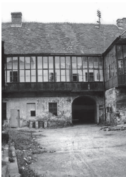
P4 Křížová č. 3. Nádvoří. Staré Brno. Foto Karel Fojtík, 1961.
