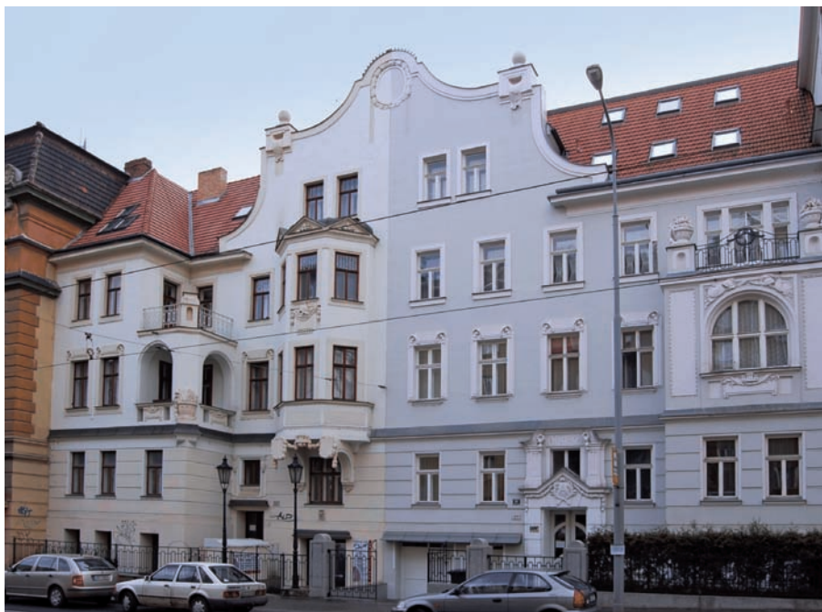
859 Nájemní domy Merhautova 20 a 22, hlavní průčelí.
