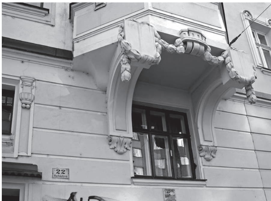
P13 Nájemní dům Merhautova 22, hlavní průčelí, detail spodní části arkýře.
