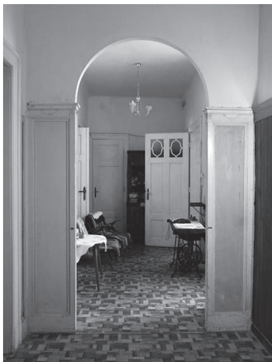
►6 Předstíh v bytě v 1. patře tzv. Švédského domu, arkáda s dřevěným obložním podpěr.
