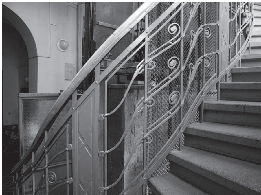
P5 Schodiště v tzv. Švédském domě, detail zábradlí.
