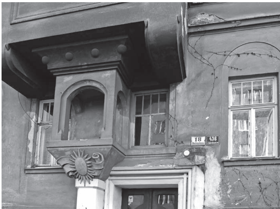
P12 Nájemní dům Merhautova 18, hlavní průčelí, detail spodní části arkýře.
