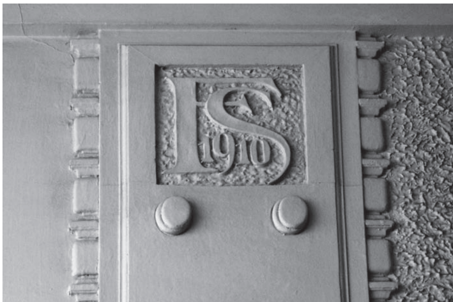
P8 Nájemní dům Smetanova 47, vstupní chodba, detail výzdoby s iniciálami stavitele Fritze Schmeera a letopočtem výstavby 1910.
