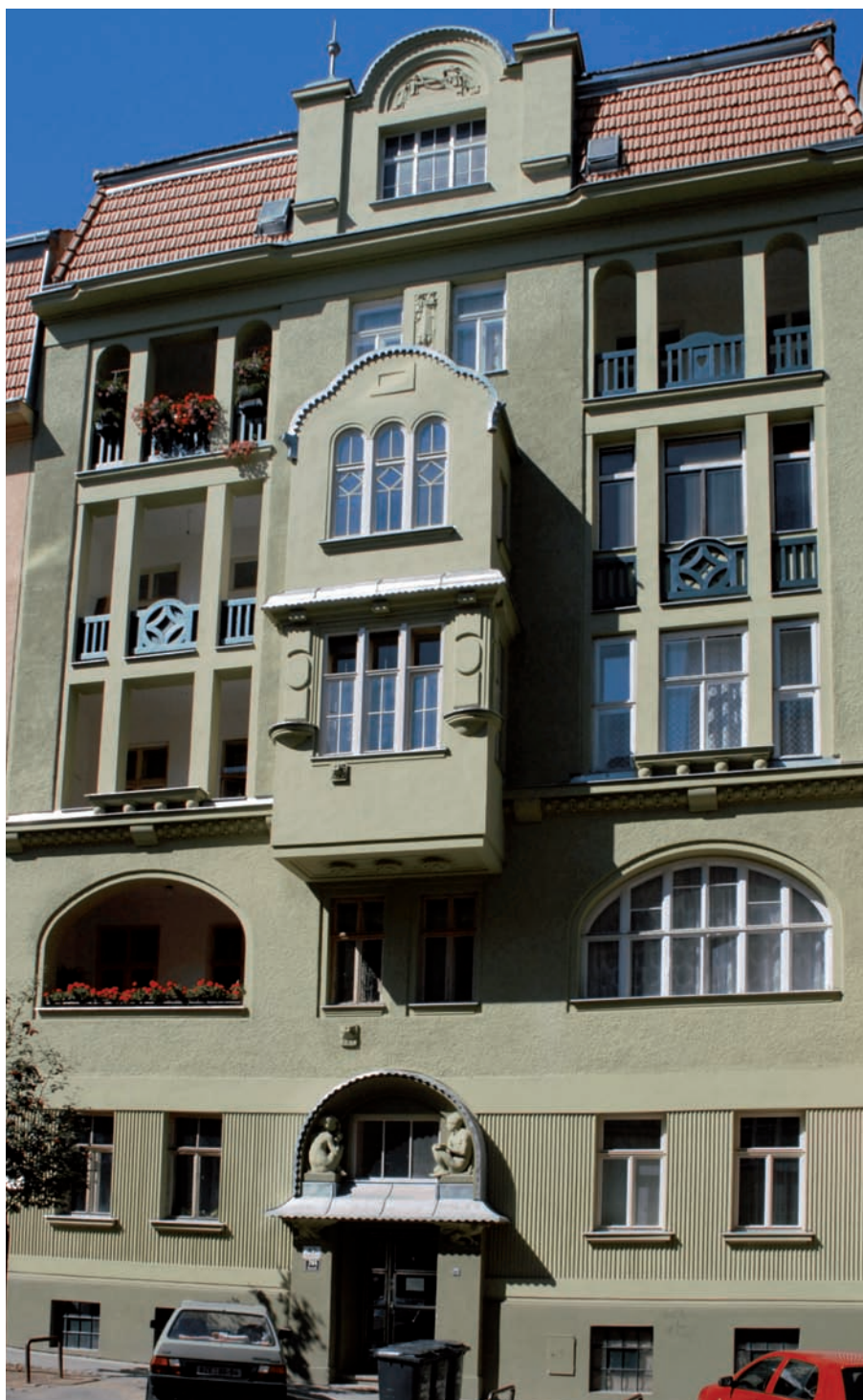
B56 Nájemní dům Smetanova 47, hlavní průčelí.
