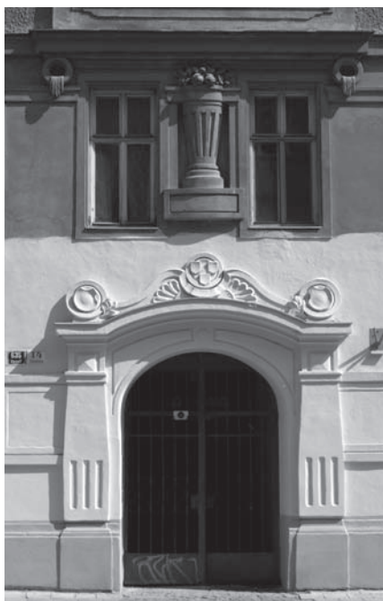
P9 Nájemní dům Cihlářská 13, hlavní průčelí, detail vstupní části.
