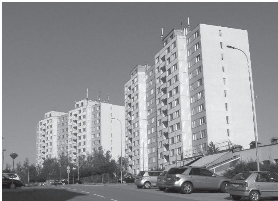
P4 Brněnské sídliště Bystrc.
