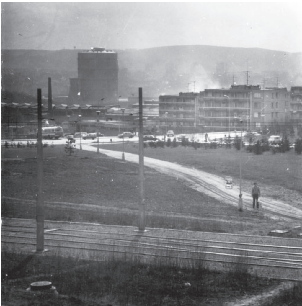
P12 Brněnské sídliště Lesná. Třískalova ulice s pohledem na Královo Pole.
