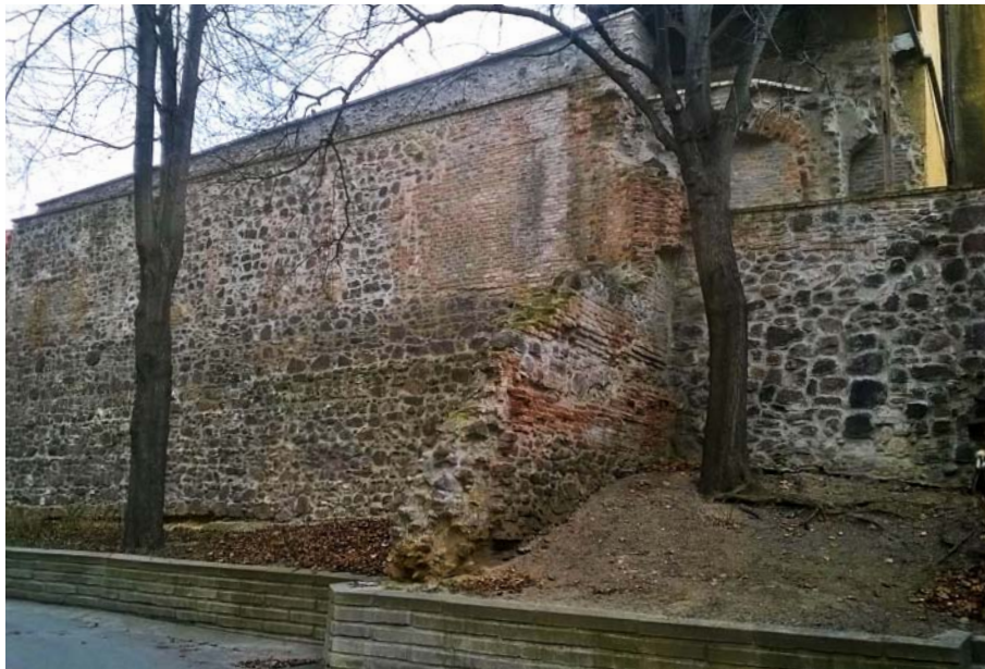
B14 Dochované pozůstatky toleranční modlitebny spojené obvodovou zdí s brněnskými hradbami.
