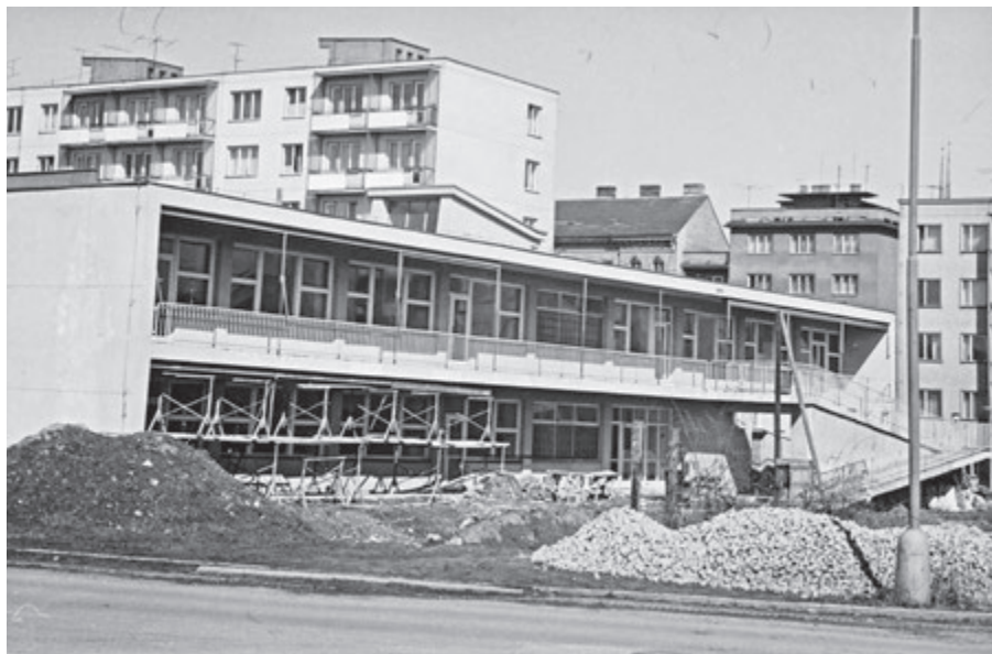
P24 Jesle (stav před dokončením), Křídlovická 371/68; 1963.
