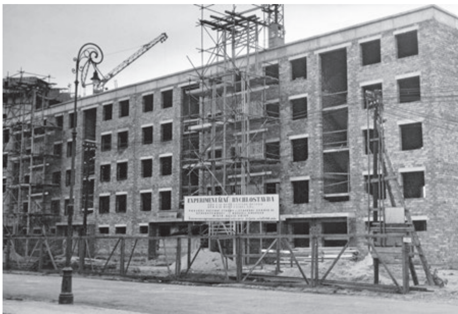
P5 Výstavba experimentálního domu A na Křídlovické ulici; 18. 8. 1960, text anotace na billboardu: Experimentální rychlostavba / Dům A 40 bytů z litého betonu / Dům B 36 bytů z cihel CD m / Provádí Pozemní stavby, n. p., Stavební správa o3 / Stavbyvedoucí: Bohumil Kirchner / Mistr: Alois Křivý / (nečitelné) Brigáda socialistické práce.
